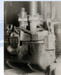
大正5年当時の1.5トンエルー式アーク炉
